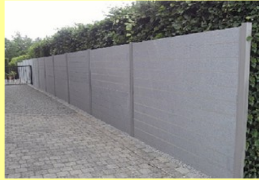
Voie d'entrée / granit gris
