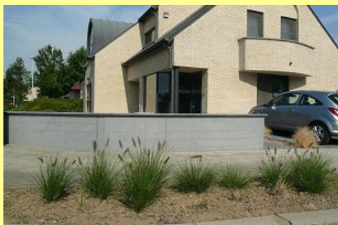
Muur in grijze graniet
